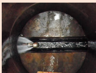
管渠清掃作業
