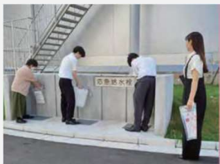
※浄水場内に応急給水栓を設置する様子
