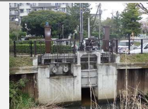
※新栄町四丁目ポンプ整備 (中川・綾瀬川緊急流域治水プロジェクト)
