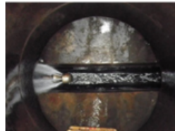
管渠清掃作業
