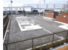
松江第2排水機場
