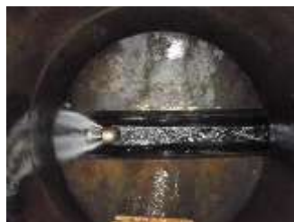
管渠清掃作業
