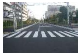
改良工事後の道路(市道2085号線)
