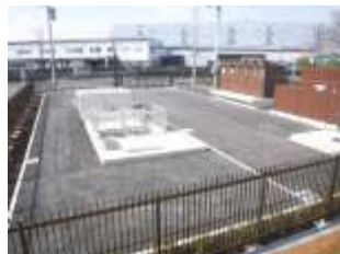
松江第2排水機場
