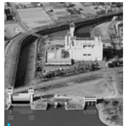
綾瀬川放水路八潮排水機場
