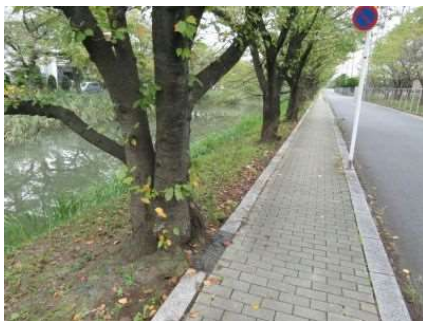
狭い植栽帯 桜が歩道の縁石に接触し腐朽
