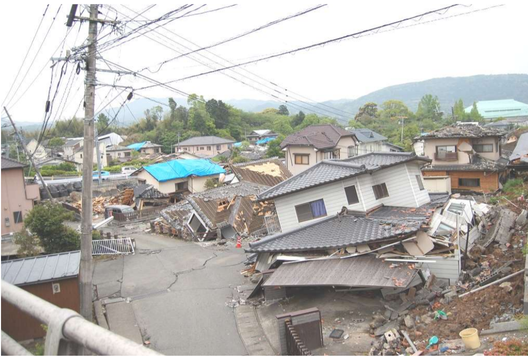
熊本地震による住宅の被害状況（提供：国土交通省九州地方整備局）
