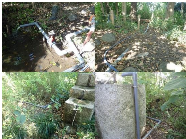
■ 水中ポンプ、配管交換後の様子
