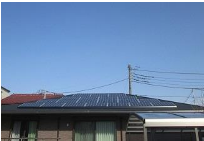
■ 太陽光発電システムの設置
