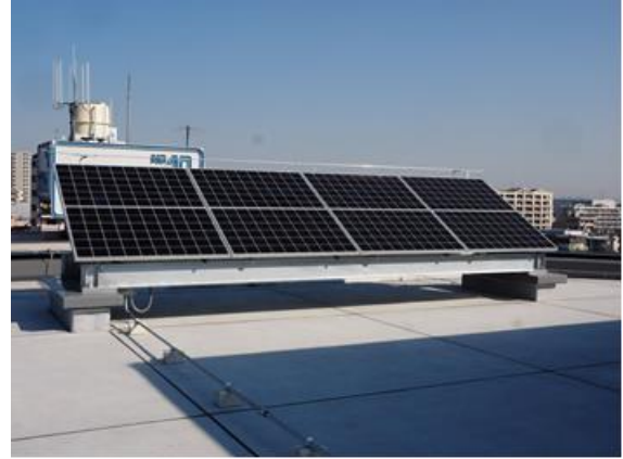
■ 市役所第二庁舎屋上
