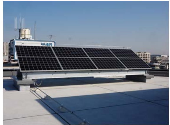
■ 市役所第二庁舎屋上
