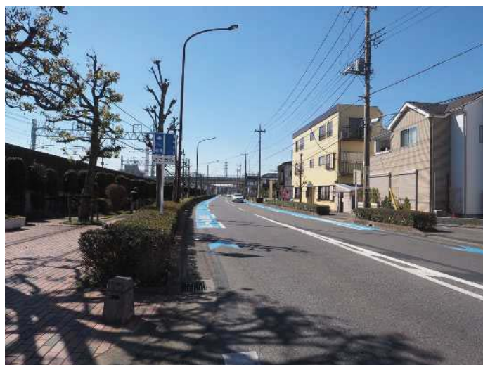
■ 整備された谷塚松原線（谷塚町）
