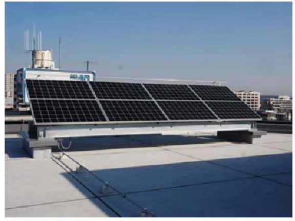
■ 市役所第二庁舎屋上
