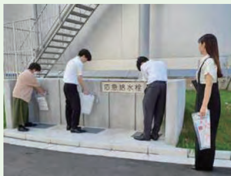
吉町浄水場内に応急給水栓を設置
